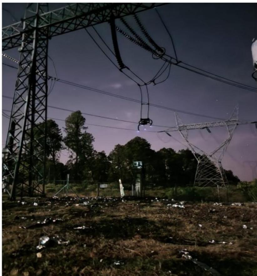
Imagen No. 1 DP dañado Fase "A" de la Línea de Transmisión DOG A
